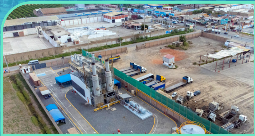
CT Pedregal: 18.6 MW
